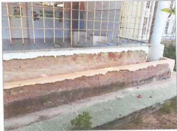
Figura 03 – Pintura Fachada Externa
