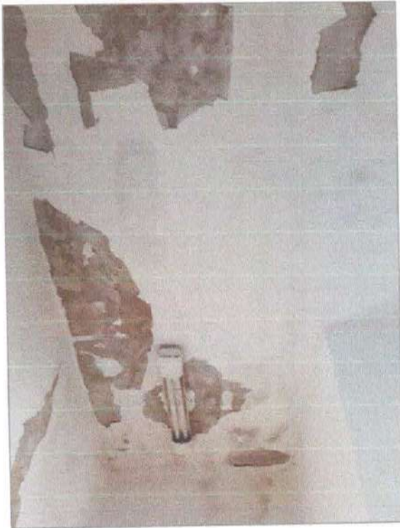
Figura 05 – Remoção de Pintura do Teto
