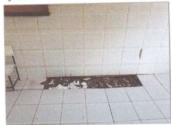
Figura 09 – Remoção e Execução de piso cerâmico
