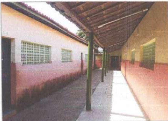
Figura 08 – Instalação de revestimento
