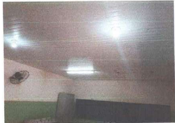
Figura 11 – Troca de luminárias e lâmpadas
