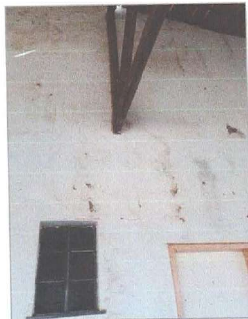
Figura 05 – Remoção de Pinturas
