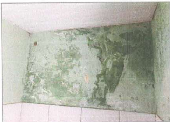
Figura 10 – Remoção de Pintura
