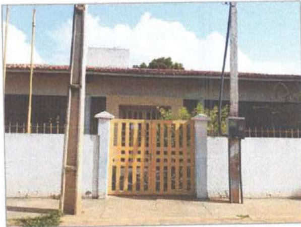
Figura 02 – Pintura com Letreiro da Fachada
