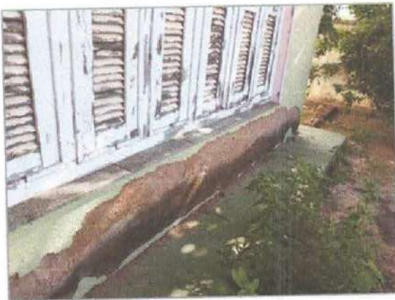
Figura 07 – Remoção de textura
