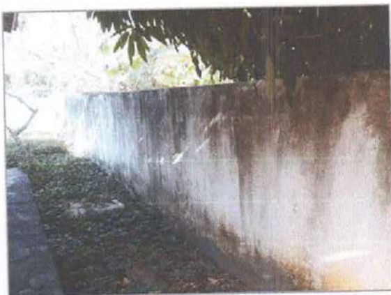
Figura 09 – Pintura de Muro - hidrator
