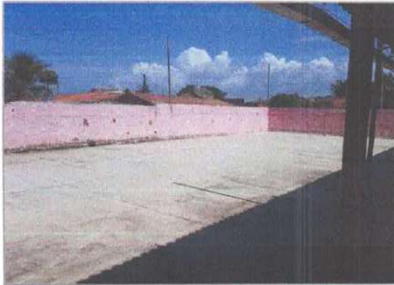
Figura 06 – Demarcação da quadra
