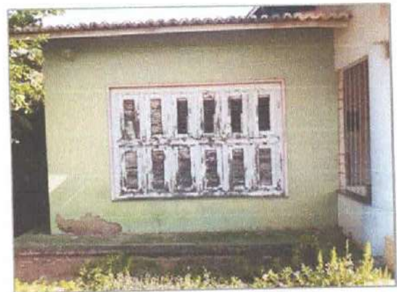
Figura 08 – Emassamento e Pintura das janelas
