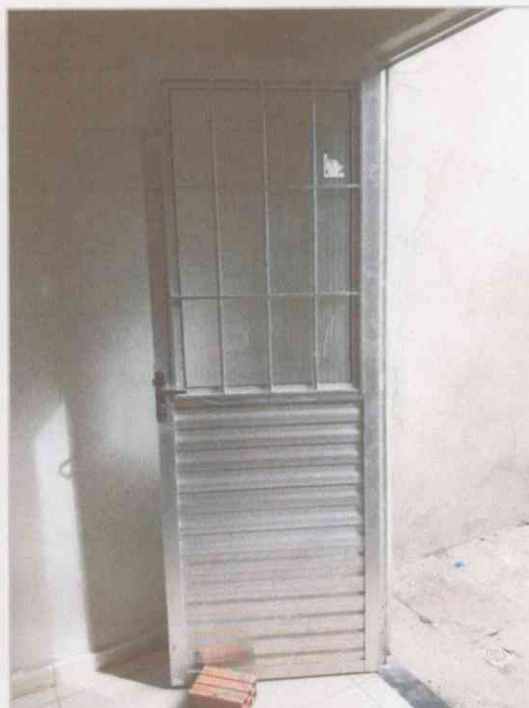
Figura 6: Porta de acesso ao Quintal
