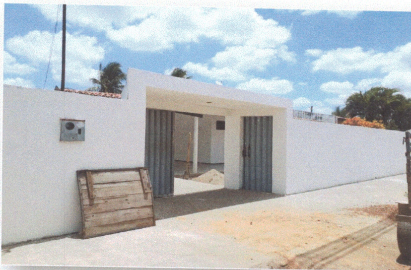
Figura 1: Fachada do imóvel.
