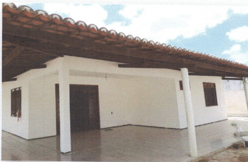
Figura 2: Parte interna – Garagem
